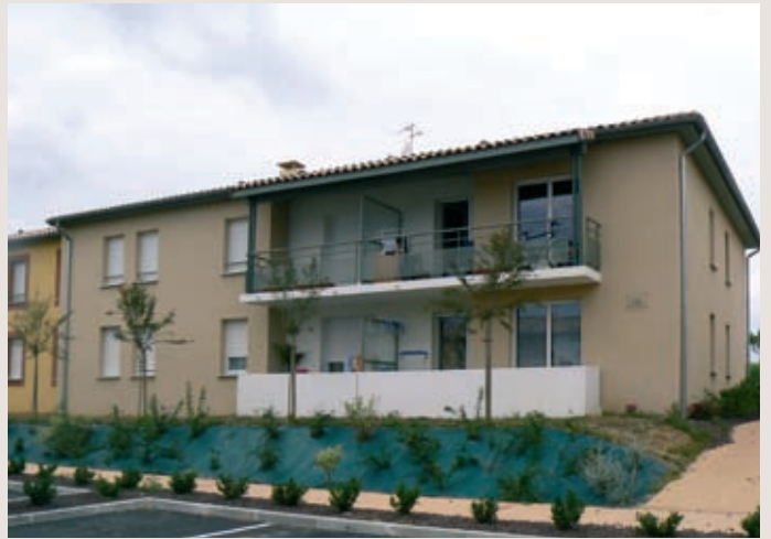
RÉSIDENCE LE BARON À MONDONVILLE : mise en location en juillet de 17 logements (5 T2 et 12 T3) - Loyer HC compris entre 283 et 410 euros Surface : de 45 m 2 à 66 m 2
