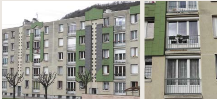
Façades de la résidence « Les Érables » à la suite des changements des portes-fenêtres.
