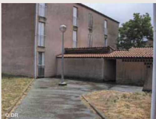
Aucamville résidence Jules Ferry : 24 logements collectifs en réhabilitation – commencement des travaux à l'automne 2010.
