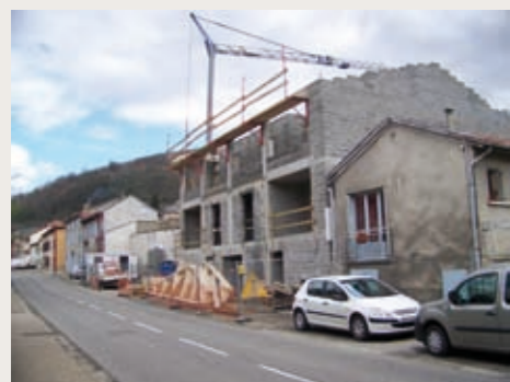
À gauche, Mercus, logement en cours de construction.
